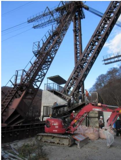
クレーン支柱の角度を調整する仕組み（左側）
